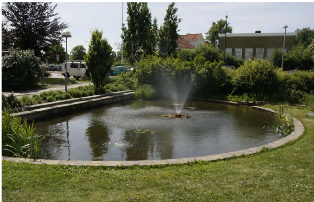
Puhdistusaltaasta tehty hulevesiallas
